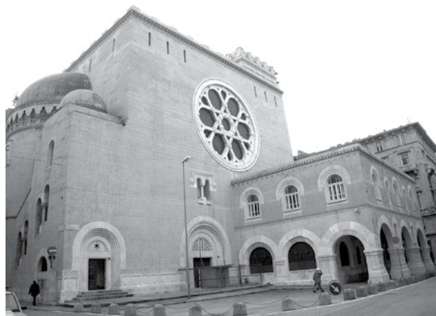
Sinagoga di trieste / Tržaška sinagoga
